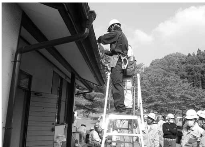
雨樋の除染作業
