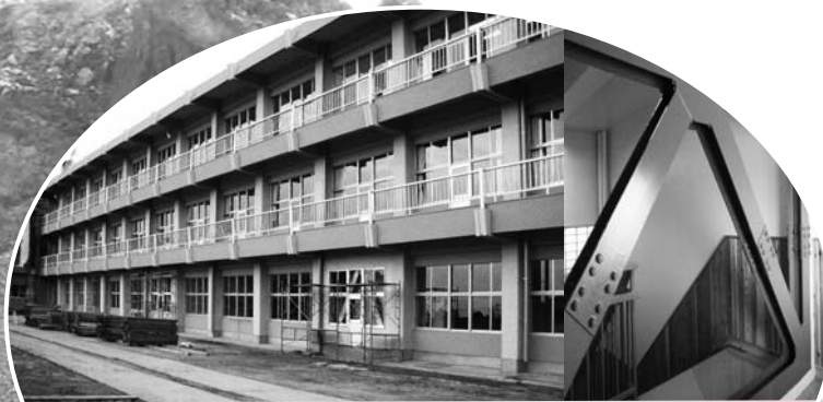
中学校校舎等耐震補強事業 那須中学校耐震補強工事 4881万円
