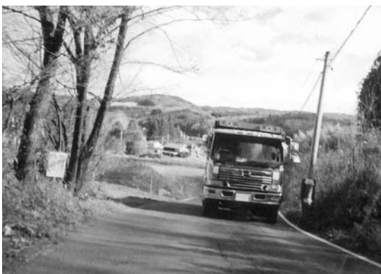
大型車輛のすれ違い困難な県道（稲沢地内）
