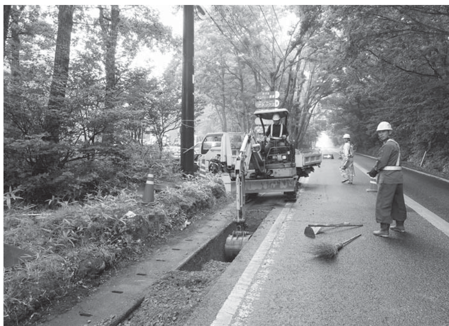
進む、老朽水道管の敷設替え工事
