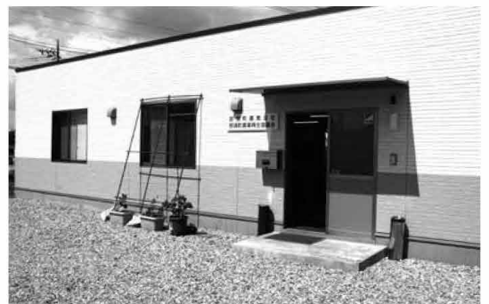
那須町農業公社（黒田原駅北側）
