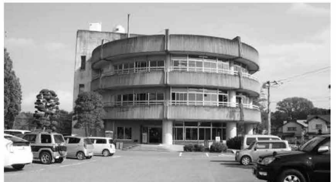
図書館耐震補強工事
