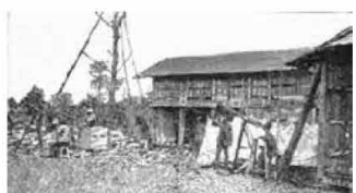
高久の愛宕山に設置された観測所
