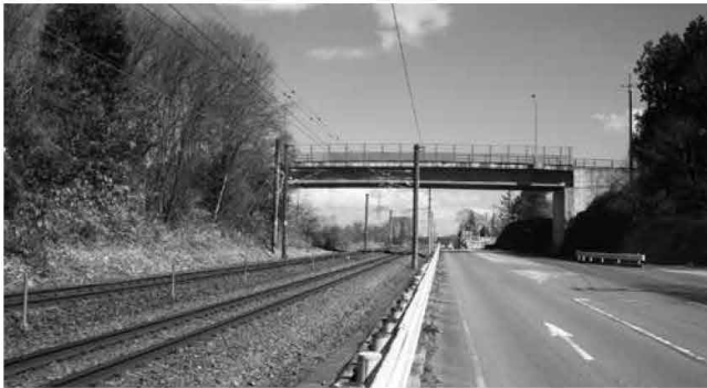
橋りょう維持補修事業（上川跨線橋）
