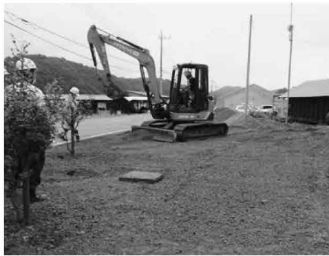
住宅の庭における表土除去作業
