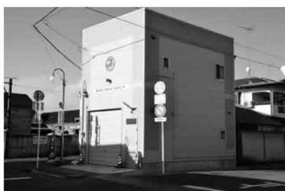
東日本大震災により被災し建て替えが行われた消防団第一分団 第一部の詰所
