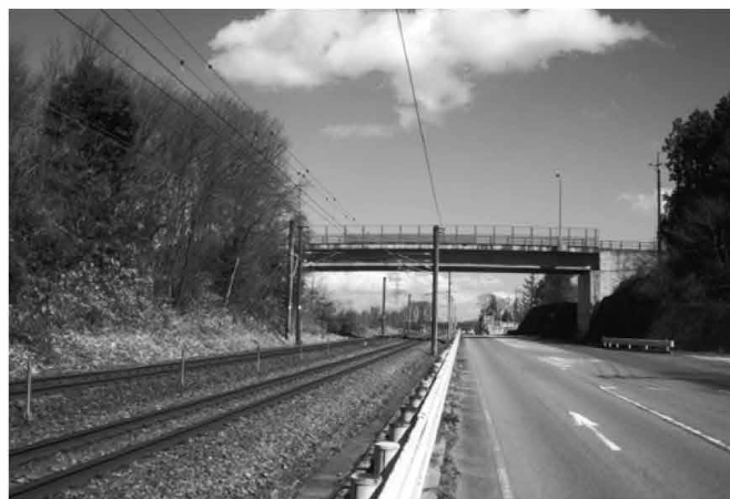
橋りょう維持補修事業
