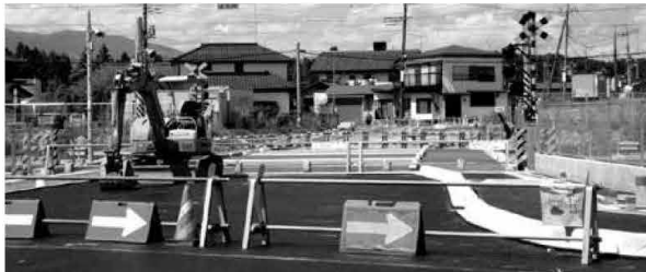
開通に向け整備を進めている小島街道踏切
