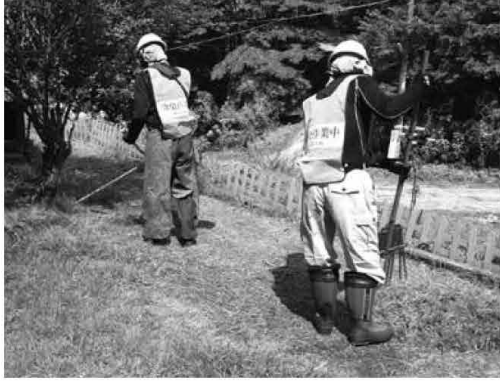
芝の深刈りによる除染作業
