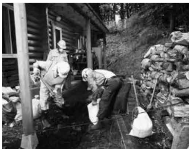
雨だれ下の表土削り取り
