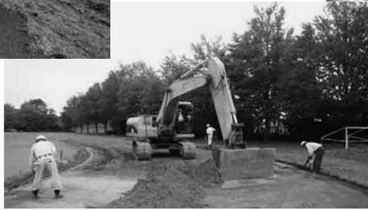
右 トラックの表土剥ぎ取り (那須町中央運動公園)
