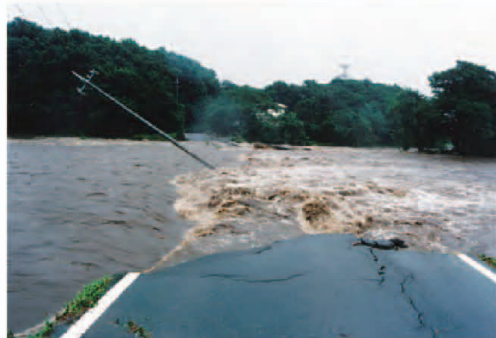
各地で道路が寸断されました(漆塚地内)
