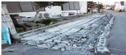
ブロック塀（補強コンクリートブロック造）
