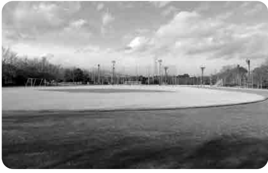
改修が期待される中央運動公園陸上トラック
