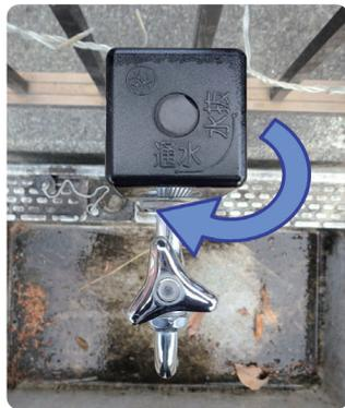
水抜きができるタイプの蛇口は上のバルブを「水抜き」（閉める）にし、蛇口を開けて中の水を抜いてください。
