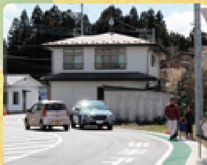
町道黒田原・高久駅線道路改良工事が完了。児童や歩行者、道路利用者の安全確保を図るため拡幅整備しました。工事中は皆さまの協力ありがとうございました
