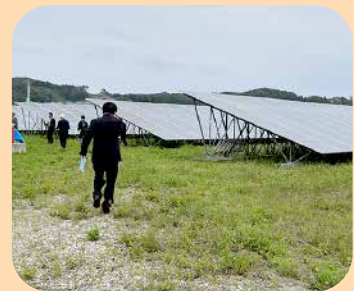
たろう 田老太陽光発電所
