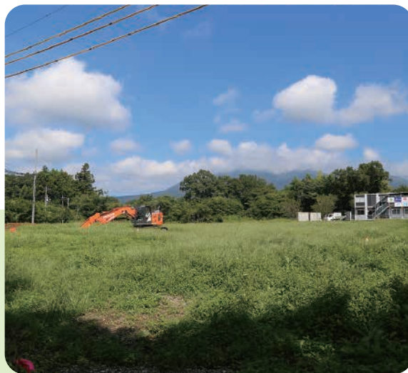
移転新築予定地
