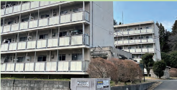
外壁等の改修工事予定のあたごハイツ
