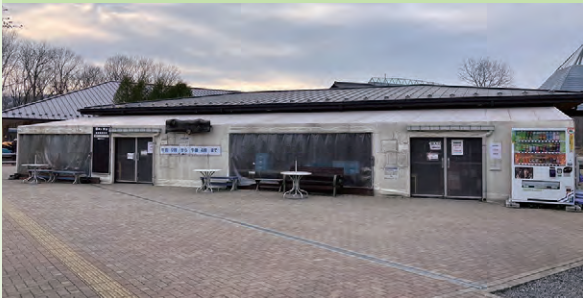
農村レストランの新築、造成工事、旧直売所の解体工事、電線の地中化等の工事
