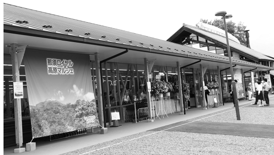
物産センターと農産物直売所を集約した新施設「那須ロイヤル高原マルシェ」
