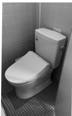
校舎内トイレの新規設置
