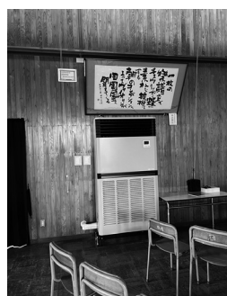
エアコンの新規設置
