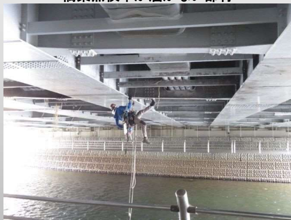
― 橋梁点検車が届かない部材 ―
