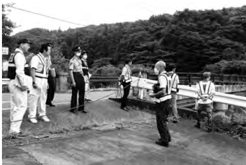
現場検証の様子（大谷開拓橋）
