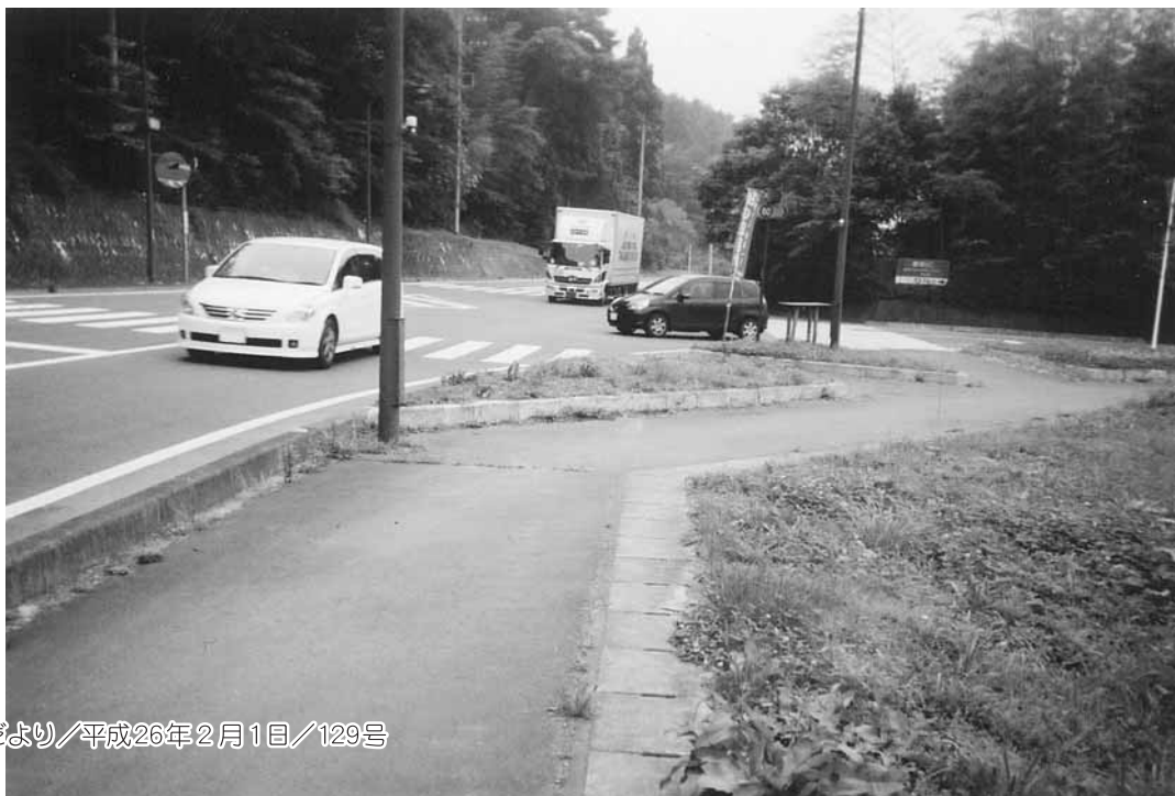
国道294号睦家地内信号機のない芋淵丁字路
