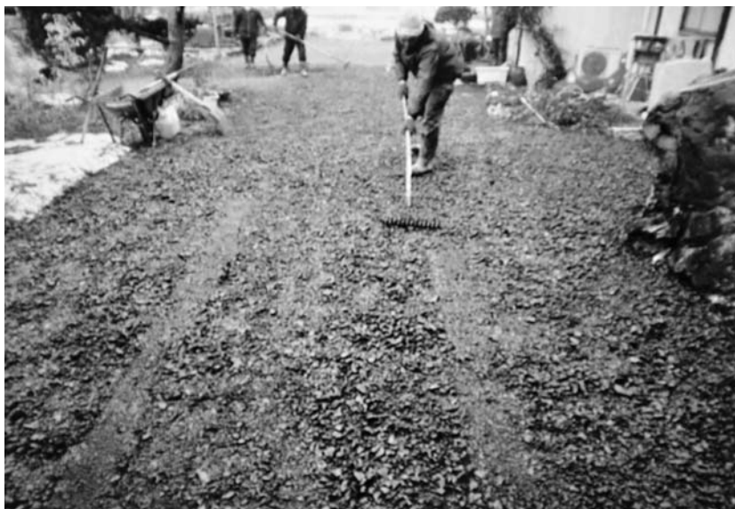
除染作業の様子
