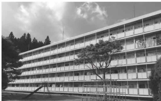
那須町定住促進住宅
