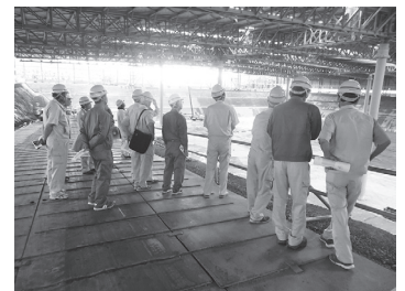
第2エコパーク(仮称)建設現場
