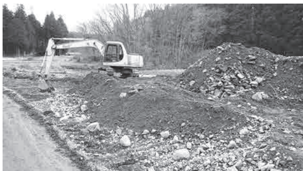
一刻も早い復旧を。復旧工事現場
