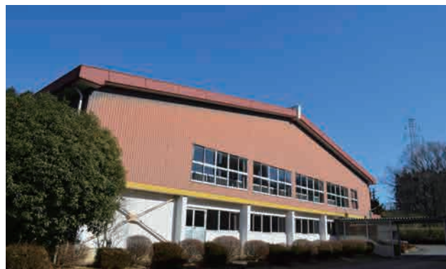
【旧田中小学校 体育館】
