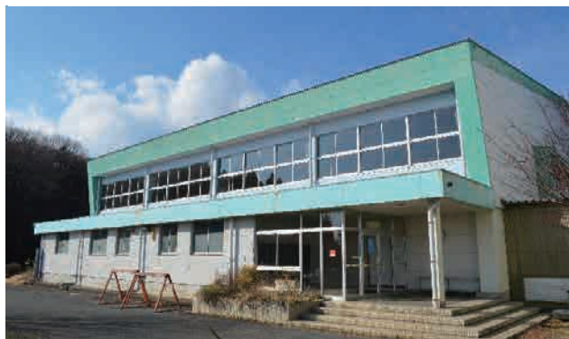
【旧朝日小学校 体育館】
