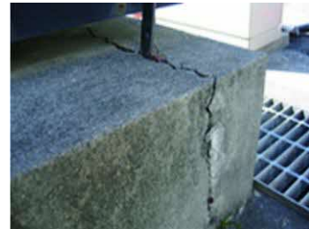
基礎にクラックが入った状態
