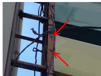
ボルトのゆるみや欠落した状態
