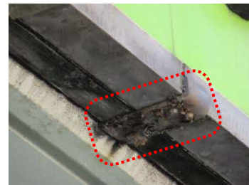
金具が劣化した状態
