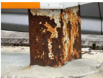
支柱根元の腐食が進行した状態
