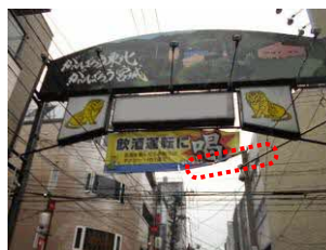
幕材を張る部材が破損した 状態
