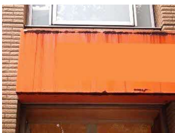
側板の腐食が進行した状態
