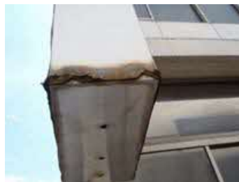
広告板底部の腐食
