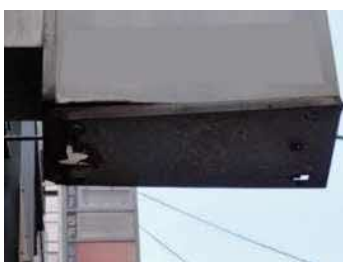
側板底面が腐食、破損、変形した状態
