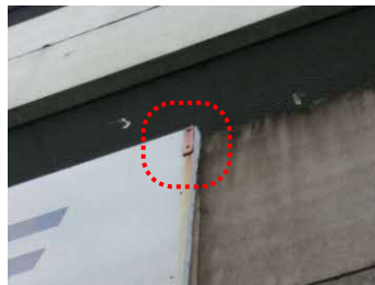
金具が劣化した状態
