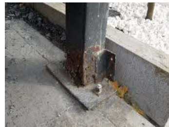
支柱根元の腐食が進行した状態
