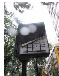
シート材がはがれかかった状態
