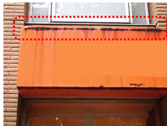
その他（塗装剥離、腐食など）
