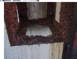
支持部が腐食していた看板の例
