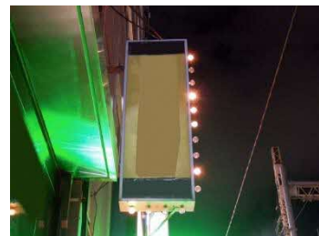
照明の不点灯
