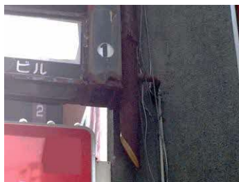
支持部が腐食した状態
