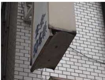
その他 (塗装剥離、腐食など)
