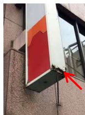
広告板底部の腐食が進行した状態
