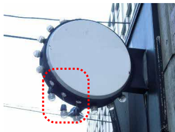
照明器具の傾き、外れ
