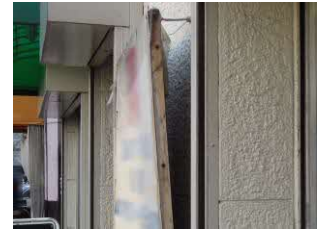
壁面との間に隙間が生じた状態
