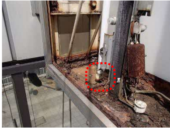
蛍光灯のホルダーが破損した状態
