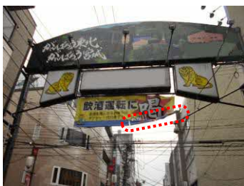
幕材を張る部材が破損した状態
