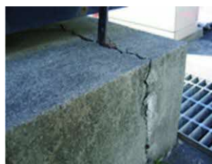
基礎にクラックが入った状態
