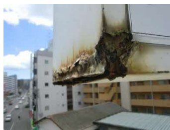
側板の腐食が進行した状態
