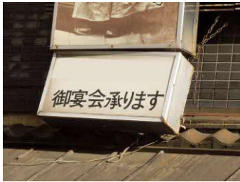
屋外広告物本体の傾き
