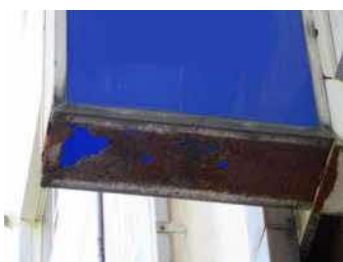
側板底面が腐食、破損した状態
