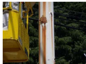
支柱の腐食が進行した状態
