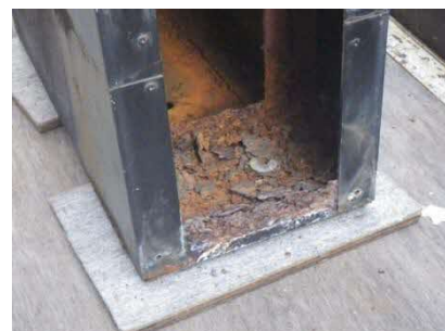
底部が腐食していた看板の例
