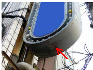
水抜き孔が詰まった状態
