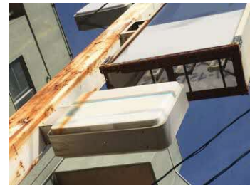
支柱にさびが発生した状態
