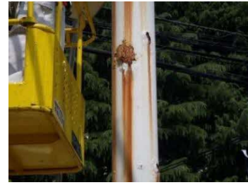
その他（支柱の腐食など）
