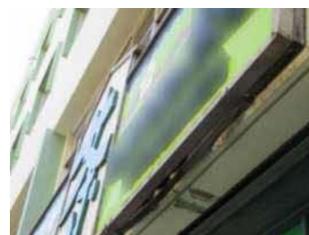
側板底面が破損した状態
