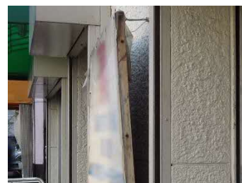
壁面との間に隙間が生じた状態
