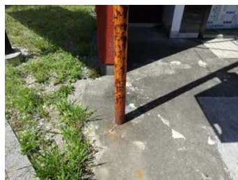
支柱の腐食が進行した状態
