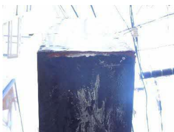
側板底面にさびが発生した状態
