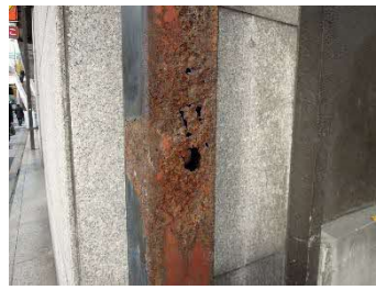
支柱の腐食が進行した状態
