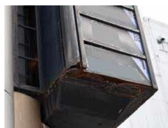
側板底面が腐食、破損した状態
