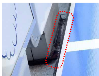
コーキングが劣化した状態
