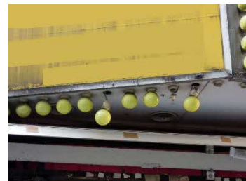
照明器具の傾き、外れ
