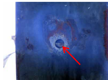
水抜き孔の詰まり
