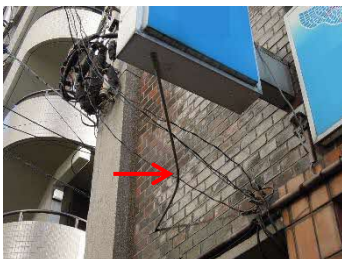
振れ止め棒が変形した状態
