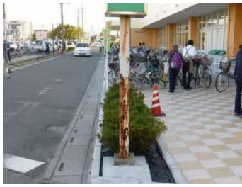
支柱の腐食が進行した状態
