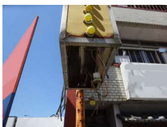
側板底面が欠損した状態
