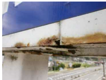
その他（塗装剥離、腐食など）
