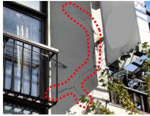
壁面にひびが生じた状態
