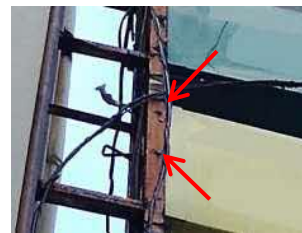
ボルトのゆるみや欠落した状態
