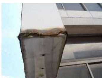
側板の腐食が進行した状態
