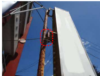
支柱・広告板接合部の腐食・隙間
