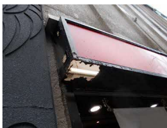
側板底面の腐食が進行した状態
