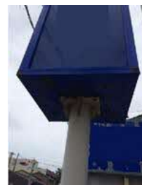
支柱・広告板接合部
