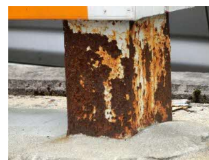
支柱根元の腐食が進行した状態
