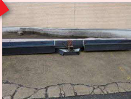
落下した欄間看板
