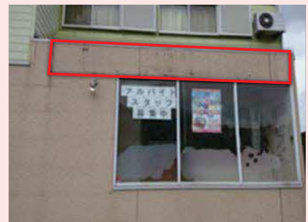
落下した後の壁面
