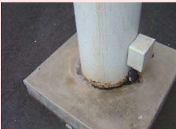
ポールの根元にサビが発生
