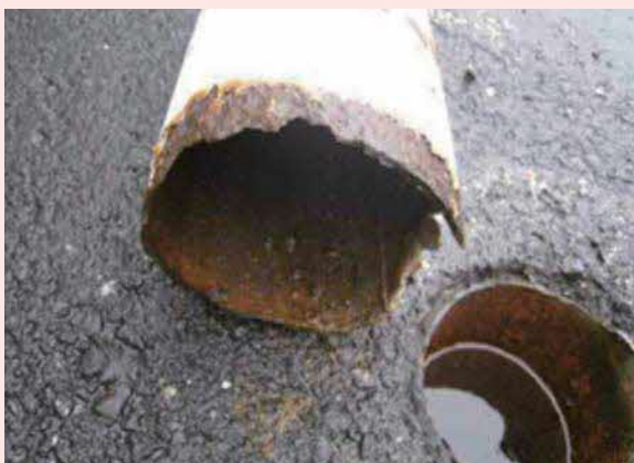
ポールの根腐れによる倒壊
