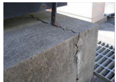
看板基礎のひび割れ
