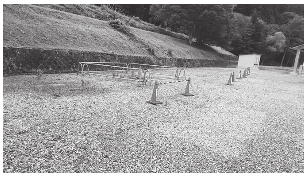
現在立ち入り禁止状況となっている現場
