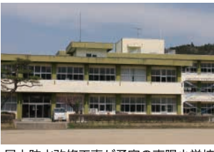
屋上防水改修工事が予定の東陽小学校
