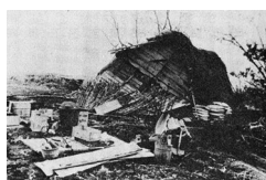
強風の被害を受けた建物
