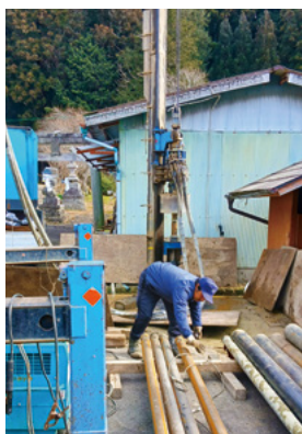
飲用井戸掘削現場の様子
